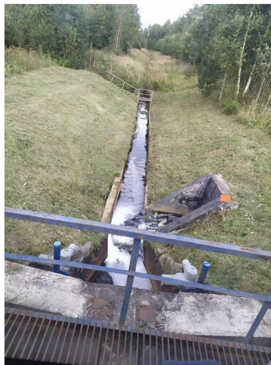
Фото 4. Водоотводной канал с территории полигона – условно чистые воды сбрасываются в водные объекты
