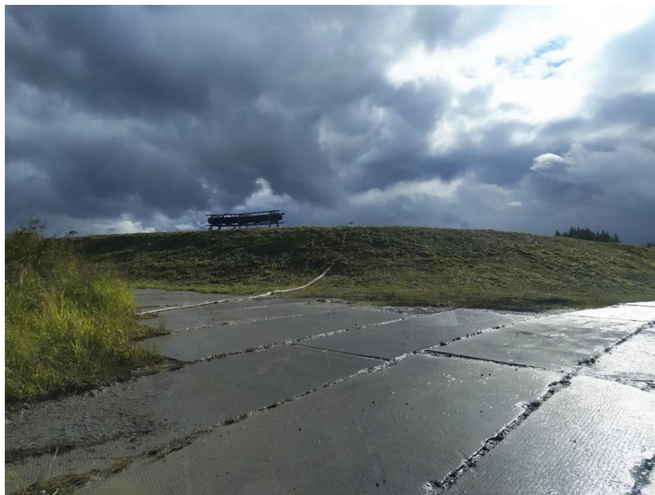
Фото 11. Рукав пожарный – может свидетельствовать о выкачивании жидкой фракции в обход очистных сооружений
